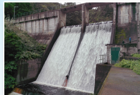
Central Hidroelétrica de Além Fazenda Além Fazenda Hydroelectric power plant
